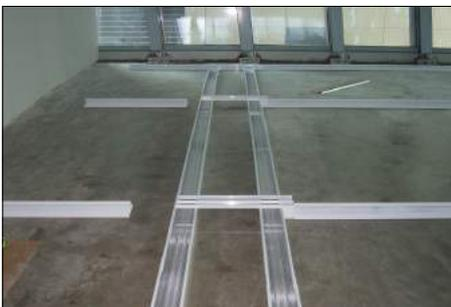
Underfloor Trunking과 U.T Pole 결합 관로공사 (WF70 + WD70)
