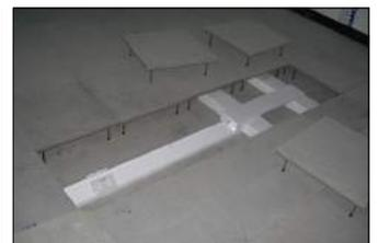
Access Floor 내부의 Underfloor Trunking과 U.T Pole 결합설치 상태
