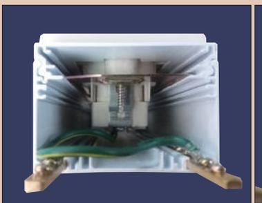
U.T Pole 본체에 Cover가 장착된 상태에서의 접지본딩선(Pig-Tail) 연결 상태
