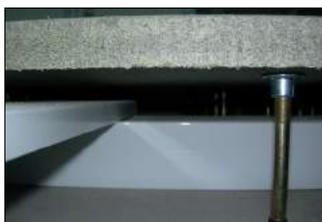
Access Floor(100H)내의 Underfloor Trunking과 U.T Pole 결합설치 상태
