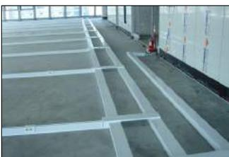
Underfloor Trunking과 U.T Pole 결합공사 및 배선공사 완료 (Access Floor 설치전)
