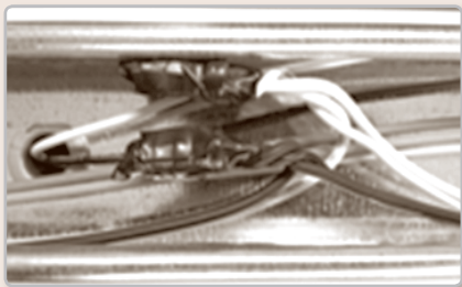
[사진 1] (기존) RACE-WAY 방식 - 표시방식이 없는 내외부 배선 결선
