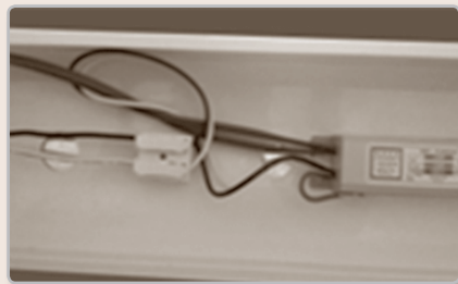
[사진 1] (기존) RACE-WAY 방식 - 표시방식이 없는 내외부 배선 결선
